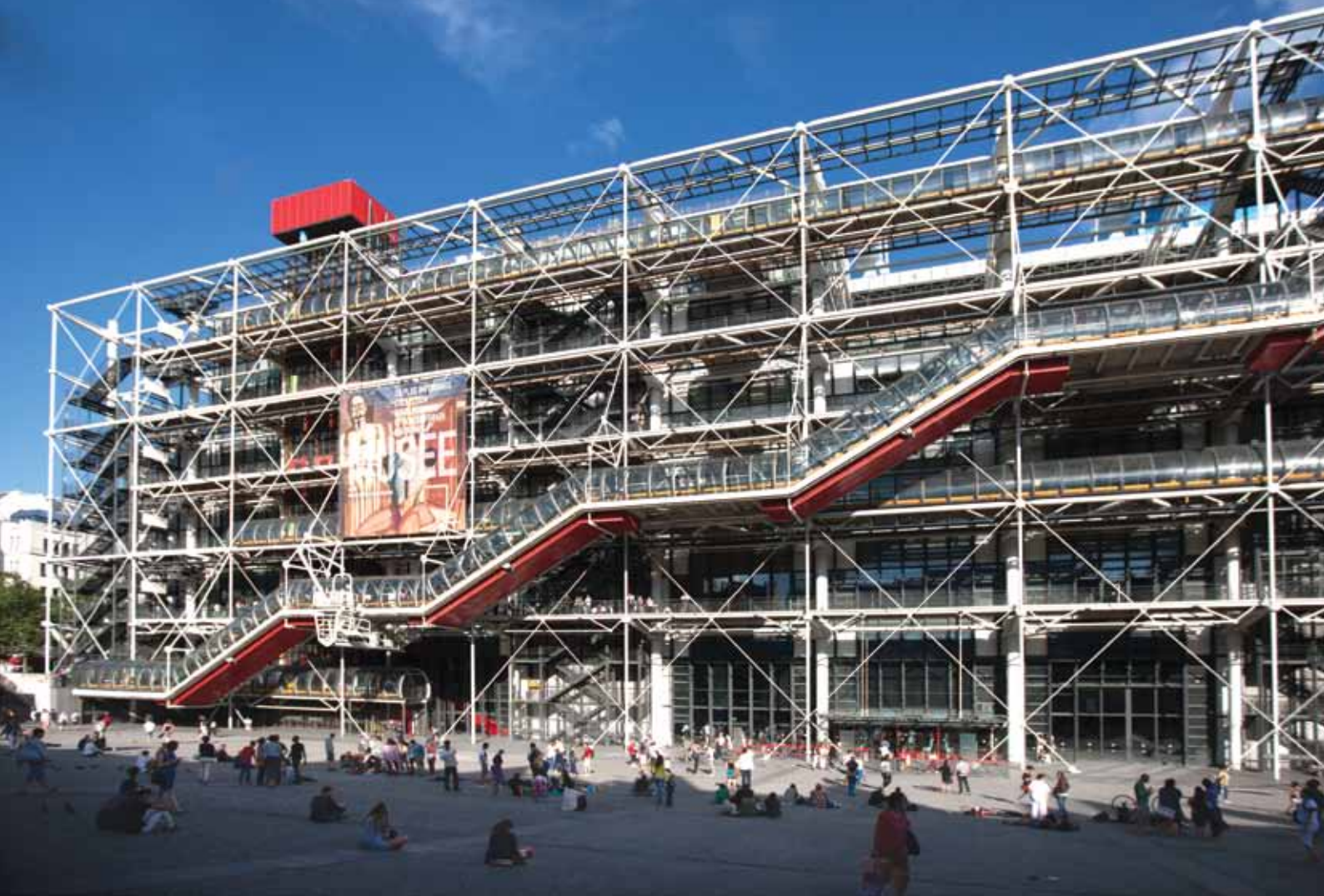
Centro Pompidou (París). Su fachada, con los elementos funcionales, conductos y escaleras, visibles desde el exterior, logra una expresión sinfónica.
