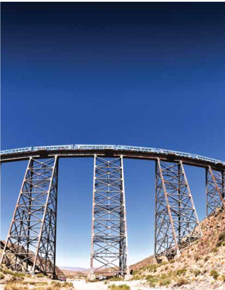
El Tren a las Nubes, llegando al viaducto La Polvorilla a 4200 msnm.
